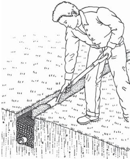
4. Все уложенные «елочкой» трубы засыпают гравием и закрывают слоем пластмассовой мелкоячейной сетки, чтобы предотвратить засорение дерн илом. На требуемом уровне, определяемом по структуре почвы, сверху сетки помещают слой плодородной почвы, тем самым завершая засыпание труб, и при необходимости укладывают на место дерн
