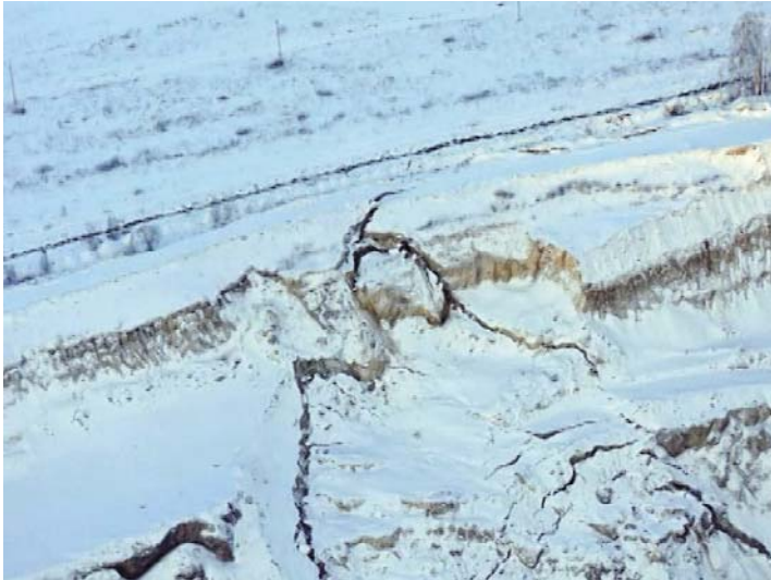
Рисунок 2 – Оползень на борту карьера
