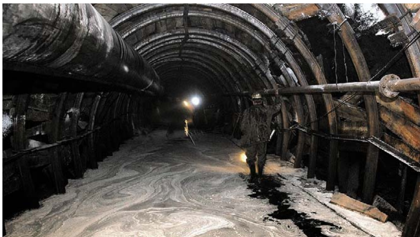
Рисунок 1 – Обводненная подземная горная выработка
