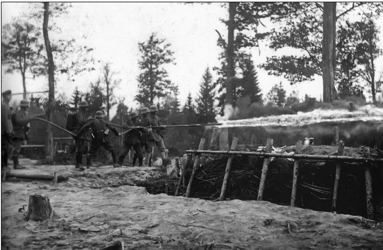
Отработка применения огнемета «Кляйф» модификации 1917 г. с удлиненным шлангом («спаренного огнемета»), чтобы обеспечить маневр огнеметчику с брандспойтом, оставляя баллоны в укрытии.
