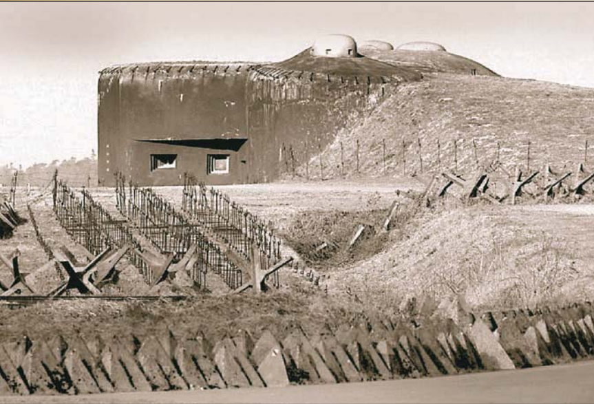
Бункер чехословацкой линии укреплений в Судетах, так называемой линии Бенеша. 1938 г.
